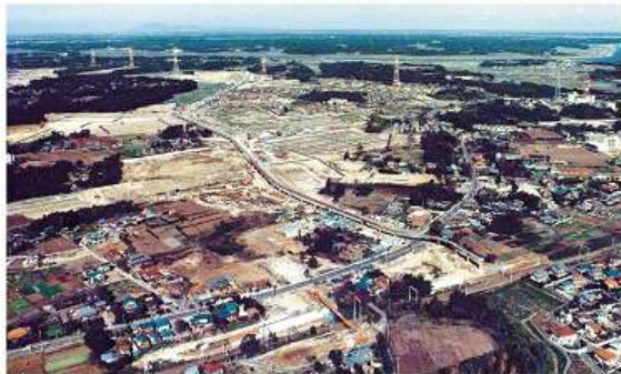
写真上段4枚及び中段は開業当時 下段は工事中
