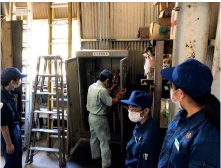
現車訓練（車庫建屋内より出庫1）
