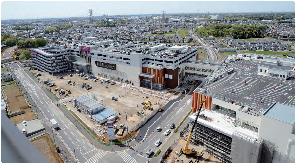
オープンに向けて急ピッチで工事が進むイオンタウンユーカリが丘(西棟・東棟は上空通路でつながります)
