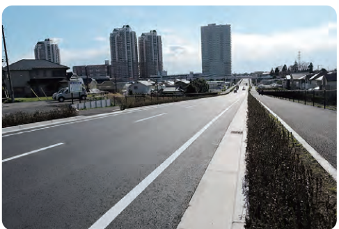
開通した国道296号線八千代バイパス上座区間
