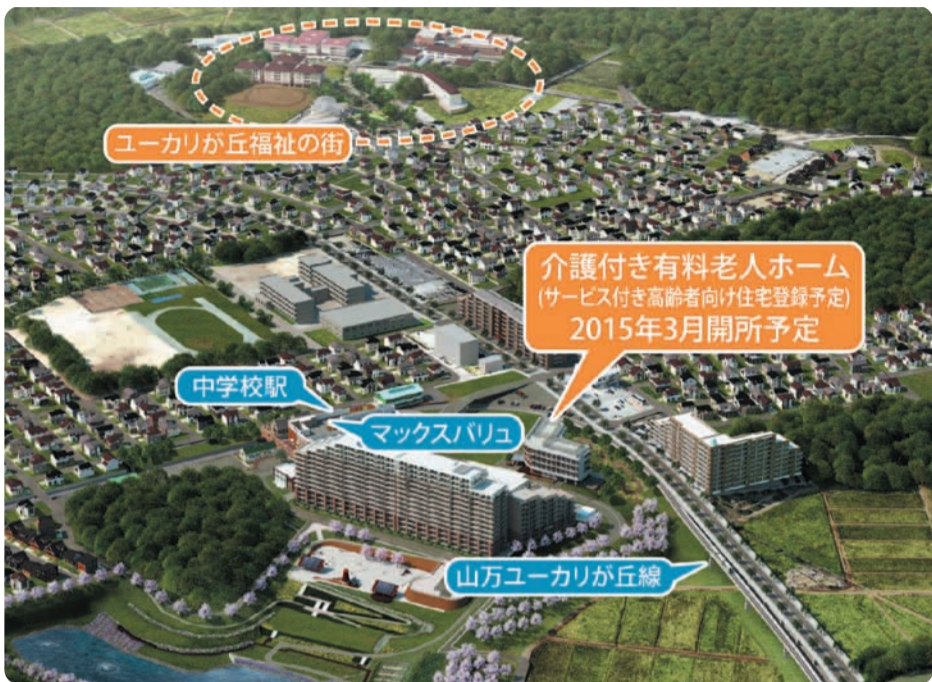
介護付き有料老人ホーム建設予定地
