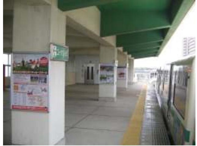
【ホーム階:EV及び警告・誘導ブロック】
