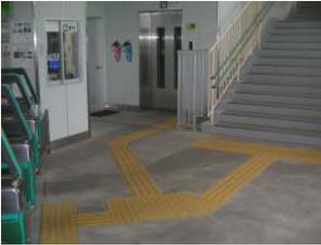
【改札階:EV及び警告・誘導ブロック】
