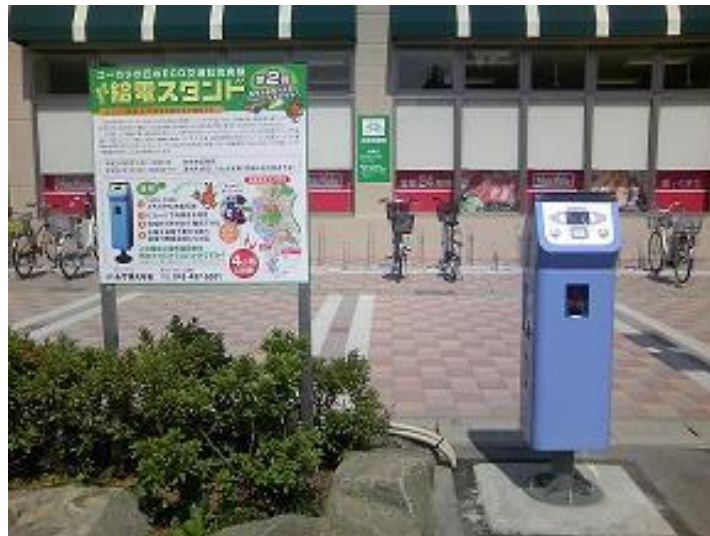
設置された給電スタンド
